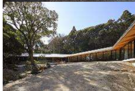
西部ガスグループ 油山研修所建替 (2月完成・福岡県)
